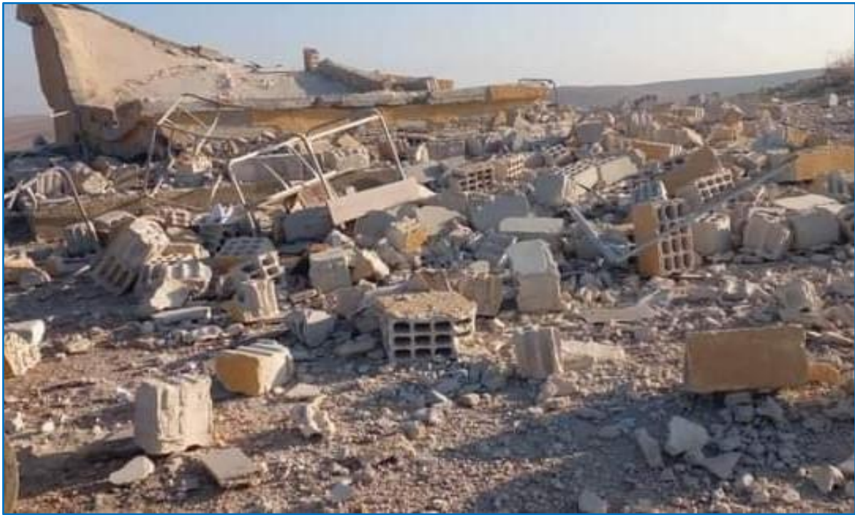
صورة تُظهر الدمار الذي لحق بمدرسة قرية "كوران" الابتدائية بريف كوباني، نتيجة تعرضها لقصف جوي تركي بتاريخ 20 تشرين الثاني/نوفمبر 2022. مصدر الصورة: هيئة التربية والتعليم – إقليم الفرات.
