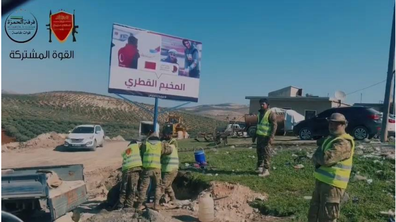
صورة رقم (4) - صورة مأخوذة من الفيديو السابق، تُظهر عناصر مسلحة يتبعون للقوة المشتركة أثناء عملية بناء المخيم.
